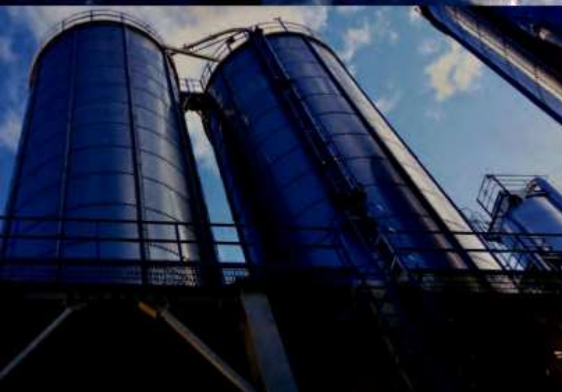
Sistema de transporte en fase densa de pellets de plástico para alimentación de silos de proceso
