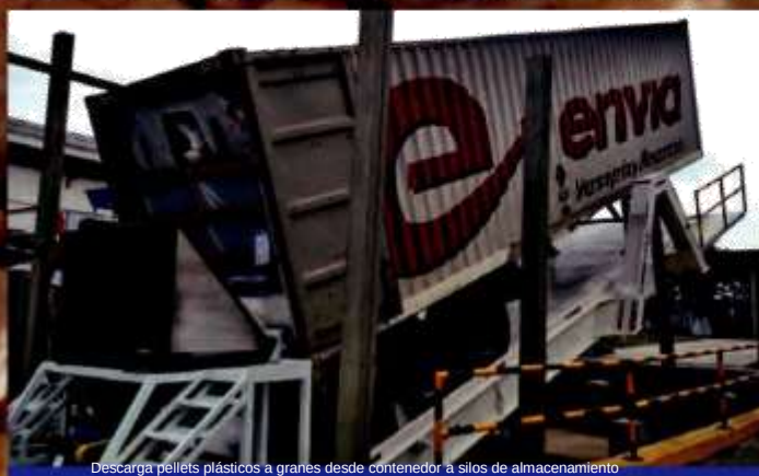
Descarga pellets plásticos a granel desde contenedor a silos de almacenamiento
