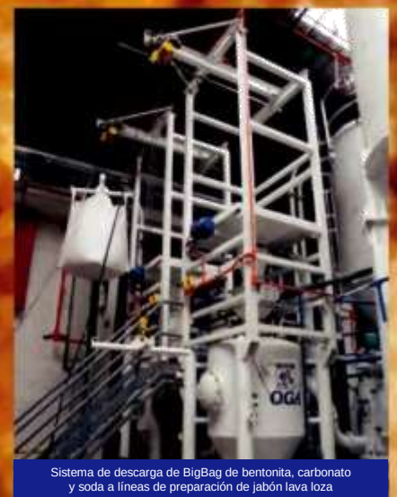
Estación de descarga de BigBag a proceso de alimentación gravimétrica de líneas de extrusión
